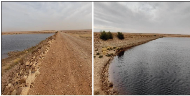
Fig. 1. Al Abila Dam [5].
